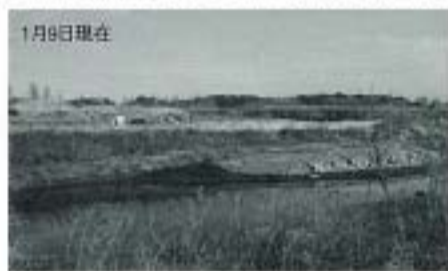
1月9日現在 手前が隆起した芝川の河床、右奥が違法盛土 中央は、変形した道路と堤防ブルーシートがかけられている
