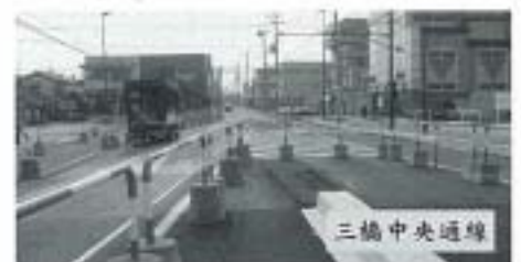
中山道の電線地中化
