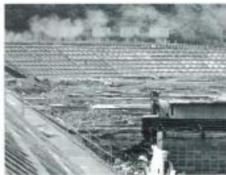
世界一とうたわれた宮古市田老地区の防波堤 津波はこの堤防をやすやすと、越えた。
