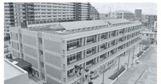
つばさ小学校の太陽光パネル
