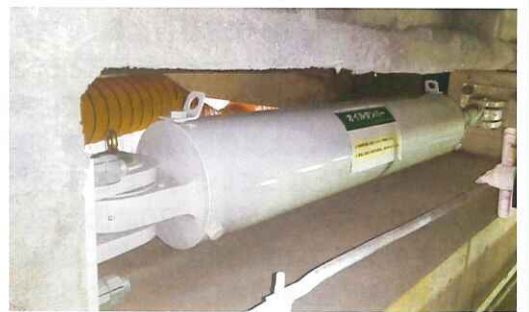
建設中の大宮区役所新庁舎に 取付られた改ざんダンパー
