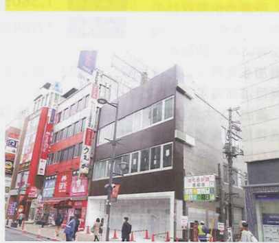
改装工事中の旧三井住友信託銀行大宮支店ビル
