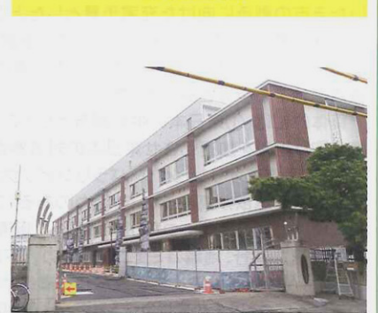
完成間近となった新校舎
